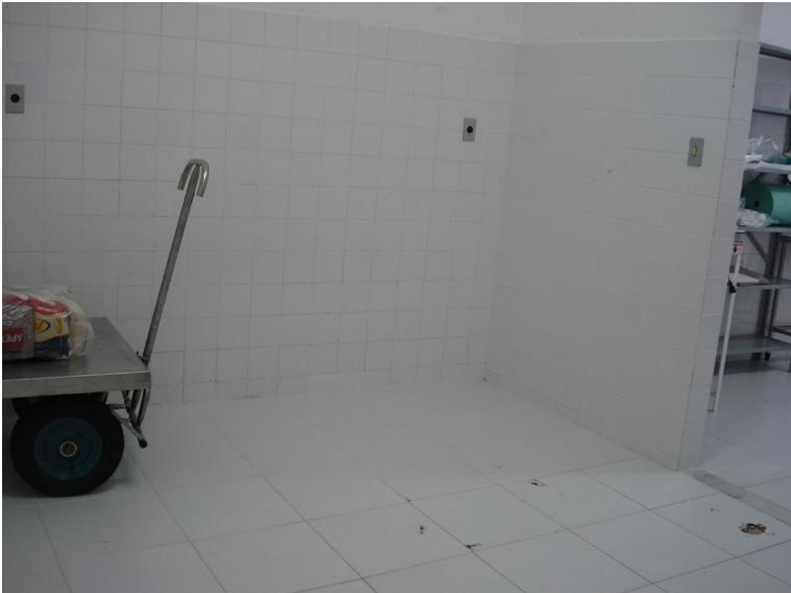
Figura 6. Setor de Estocagem (Câmara fria) do Banco de Alimentos da Região Metropolitana de Belo Horizonte, Minas Gerais.
