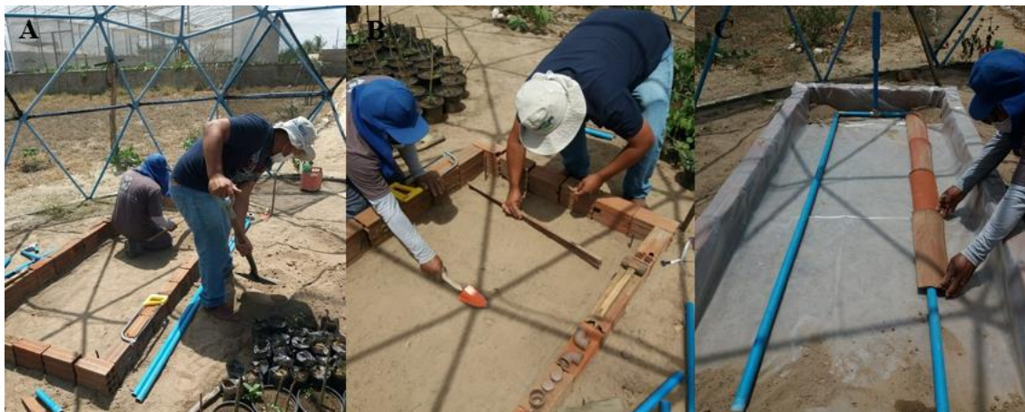
Figura 9: A) preparação dos canteiros; B) nivelamento dos canteiros e C) instalação.
